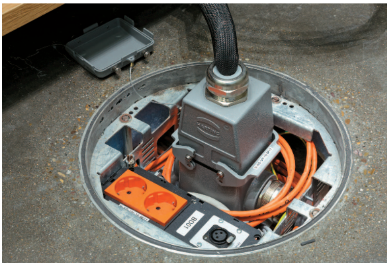
Solide Verbindung: Modular bestückbarer Harting-Stecker an einem Bodentank
